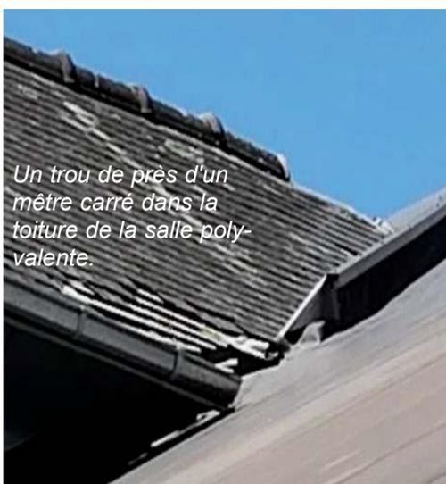
Un trou de près d'un mètre carré dans la toiture de la salle polyvalente.
